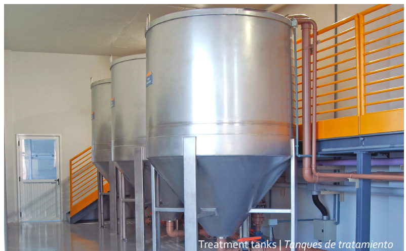
Biological treatment tanks | Tanques de tratamiento biológico
